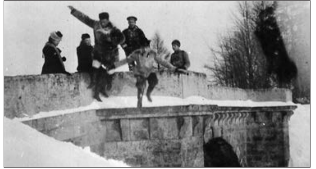
На Карпином мосту в Гатчинском парке. 1900-е. Из коллекции ГАРФ.
